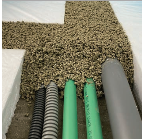
Installationskanäle mit TB 250 plan auffüllen
