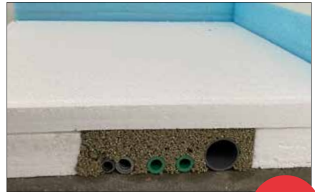
Darüber liegende Dämmschicht auslegen
