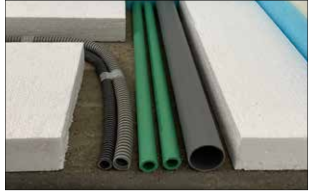
Installationsebene mit Dämmplatten des Anwendungstyps DEO auslegen
