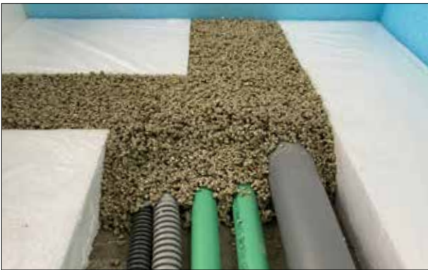
Installationskanäle mit TB 250 plan auffüllen
