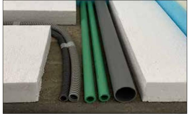
Installationsebene mit Dämmplatten des Anwendungstyps DEO auslegen
